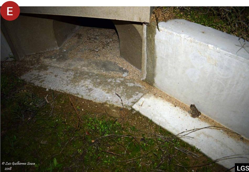
Exemplo de barreiras permanentes em betão para anfíbios e detalhes da sua instalação: (A) barreira permanente em betão colocada de forma a ligar à obra de arte, não permitindo a entrada de anfíbios na estrada; (B) extremidades em "U"; (C) integração das barreiras em faixas marginais de estradas em talude de aterro; (D) encaminhamento para PH adaptadas para atravessamento de anfíbios; e (E) encaminhamento para bocas de entrada/saída de passagem específicas para anfíbios.
