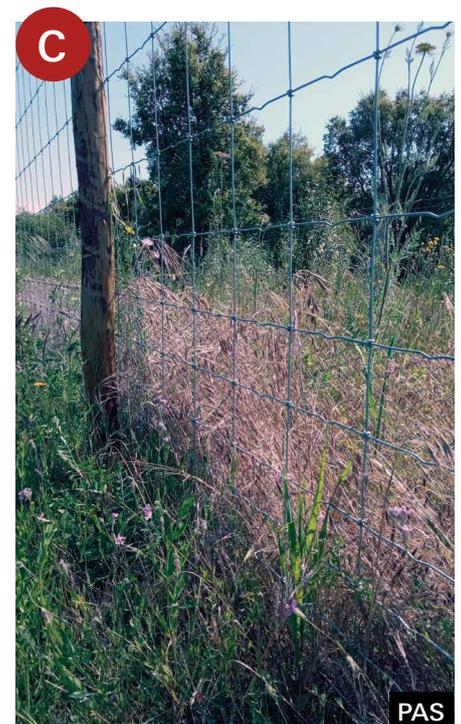
Instalação da rede em "L" nas vedações do IP2, no âmbito do projeto LIFE LINES: (A) colocação da rede em "L" junto à vedação e (B) recobrimento com terra e compactação, e (C) aspeto final da rede em "L".
