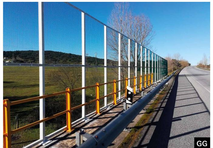
Detalhes das barreiras implementadas na EN114, com 3 m de altura (a partir da plataforma), constituídas por prumos metálicos de secção retangular RHS 80x60x3, com tampas plásticas no topo, afastados de 2 m, que permitem suportar uma malha de arame galvanizado, soldada e plastificada a PVC/poliéster, com diâmetro de 19 x 19 mm e diâmetro do arame de 2 mm. Os prumos são encastrados no maciço de fundação.
