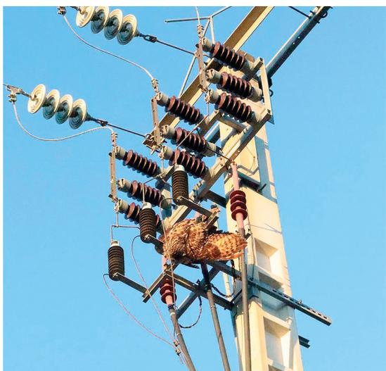
Apoio tipo **PT com Seccionador Vertical**, com um bufo-real (*Bubo bubo*) eletrocutado. Esta tipologia é a segunda com maior índice de mortalidade associado por eletrocussão em Portugal 0,31 (aves /apoio/ano).
