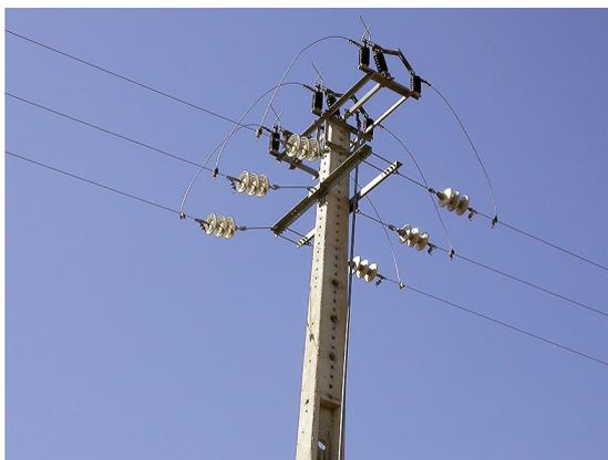
Apoio tipo **Seccionador Horizontal**. Esta é a tipologia com maior índice de mortalidade associado por eletrocussão em Portugal, sendo o valor de 0,53 (aves/apoio/ano). É um apoio com uma função de corte (interruptor) com uma tipologia cuja construção já não é permitida, apesar de ainda existirem milhares em todo o país.
